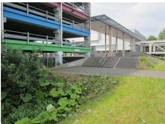
foto 5: grofvuilrooster bij voetbrug Jaarbeurs
