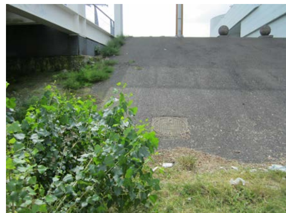
foto 6: inspectieput bij voetbrug Jaarbeurs
