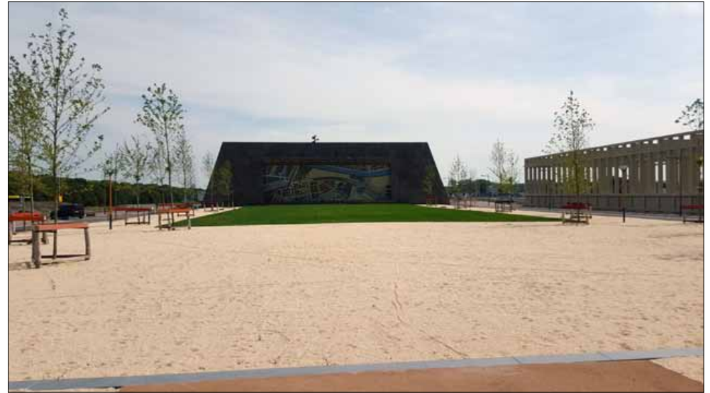
Dienstengebouw A2-tunnel, vanaf Berlijnplein
