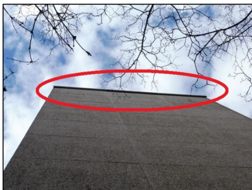
Foto 1: Zijgevel flat met openingen onder dakrand.
