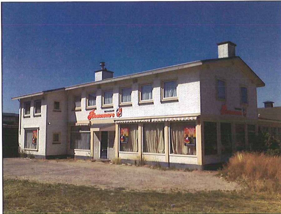
Foto 1: Overzichtsfoto onderzoekslocatie (restaurant)
