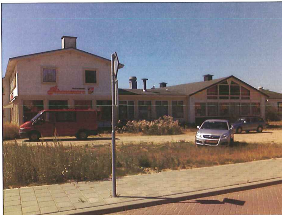
Foto 2: Overzichtsfoto onderzoekslocatie (restaurant)
