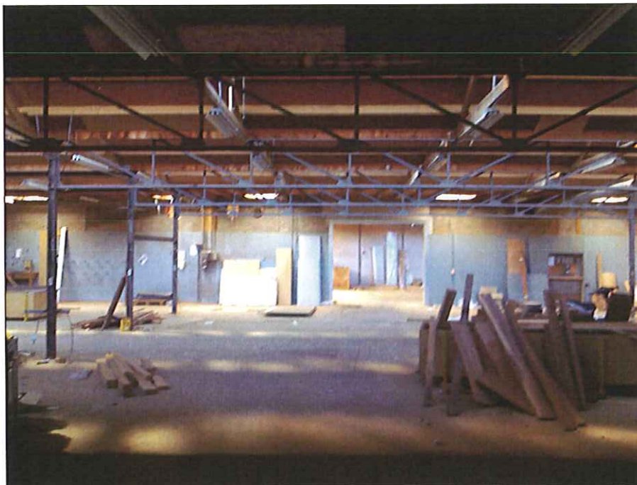
Foto 10: Overzichtsfoto onderzoekslocatie (fabriek)
