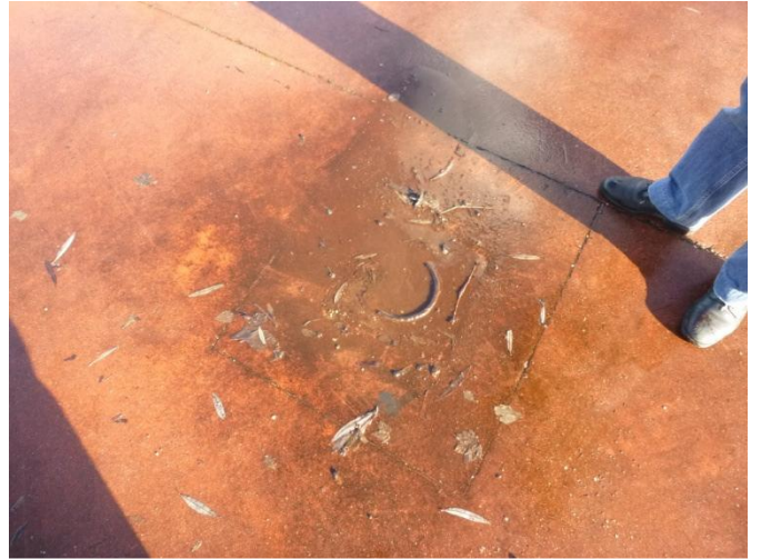
Castellumlaan, vloer van werkplaats van garagebedrijf, in het midden putdeksel.
