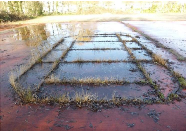
Castellumlaan, detail van werkplaatsvloer.
