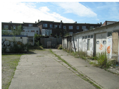
Foto 13: Bebouwing met verweerde asbesthoudende daken
