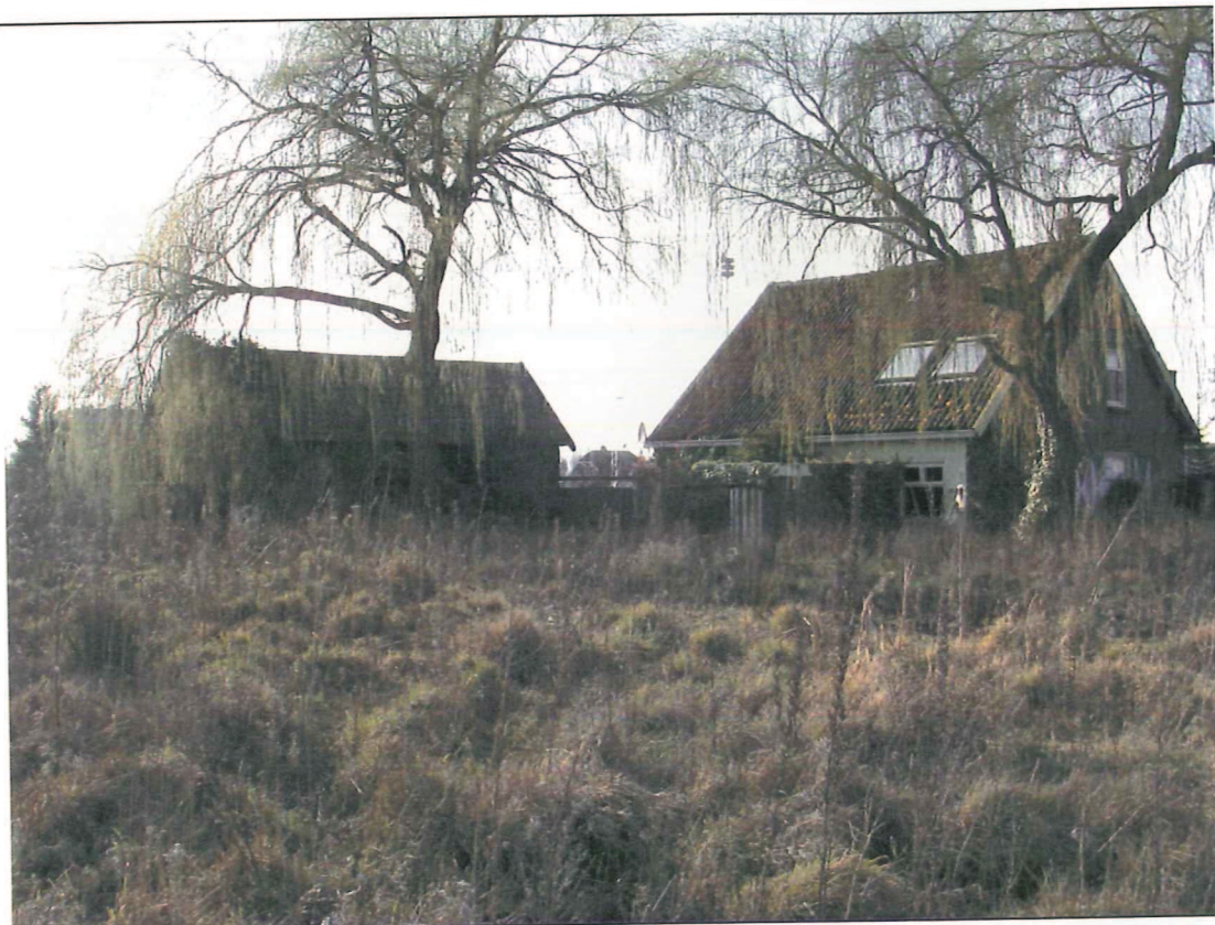
Figuur 2.2 . Impressie: wilgen die gekapt moeten worden en te slopen woning en bijgebouwen in deelgebied 4.
