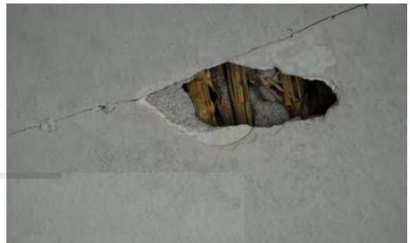
Stucplafond met riet
