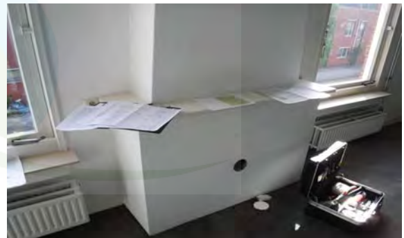
Schoorsteenkanaal niet asbestverdacht
