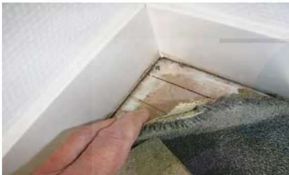
Inspectie onder vloerafwerking
