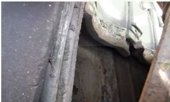
Inspectie onder de dakpannen
