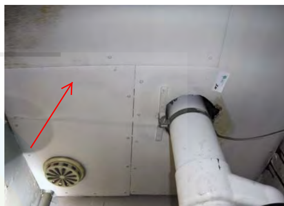
Plafond C.V. ruimte
