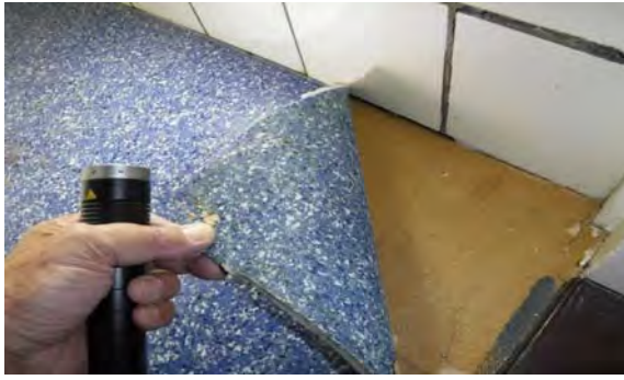
Inspectie onder vloerafwerking
