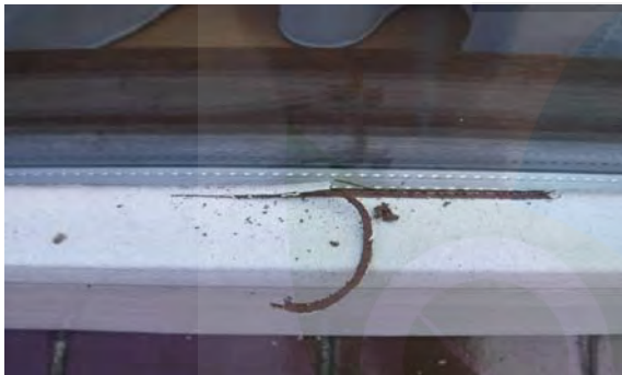
Beglazingskit flexibel niet asbestverdacht
