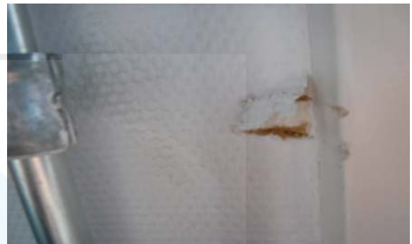
Inspectie voorzetwanden niet asbestverdacht
