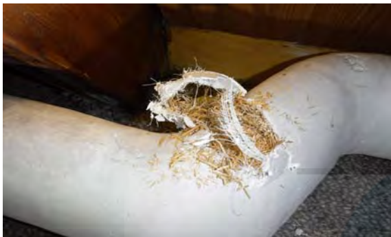
Leidingisolatie niet asbestverdacht
