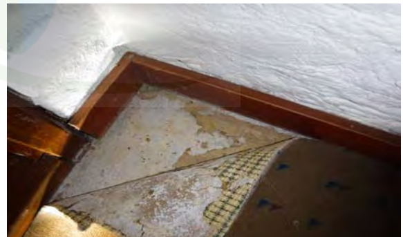
Inspectie onder de vloerafwerking
