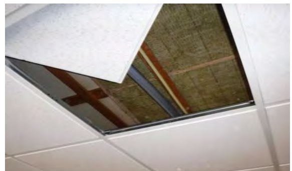
Inspectie boven systeemplafond
