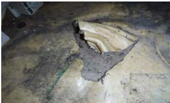
Vloerzeil niet asbestverdacht
