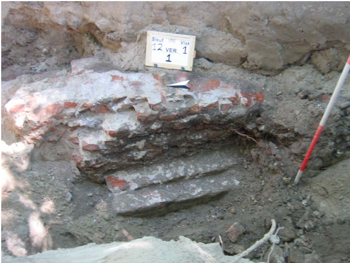
Afbeelding 3 De keermuur in sleuf 12 in 2006.
