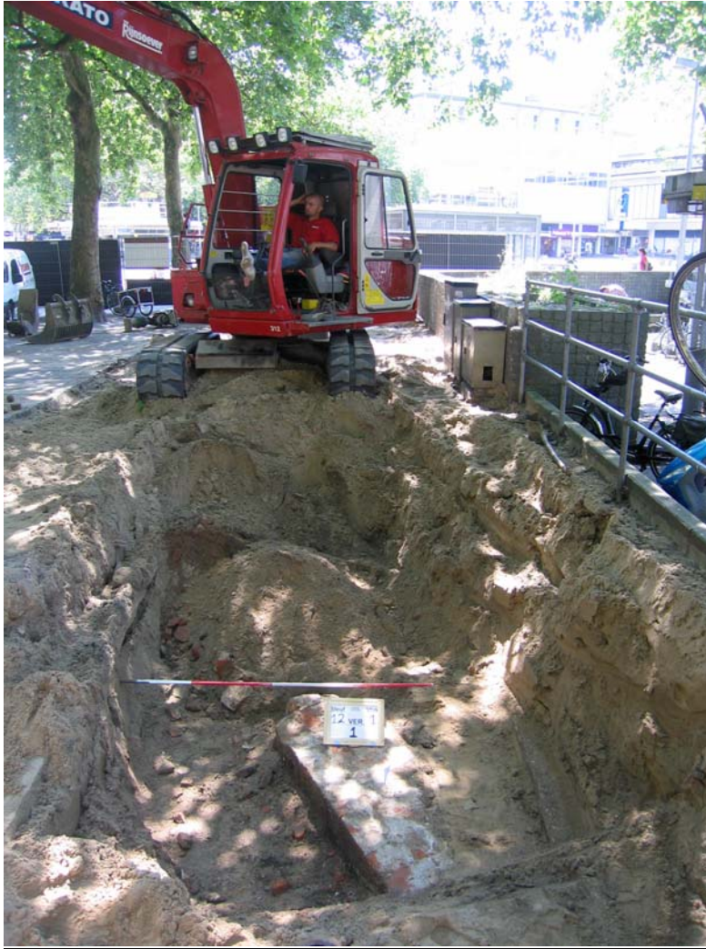
Afbeelding 2 De keermuur in sleuf 12 in 2006.
