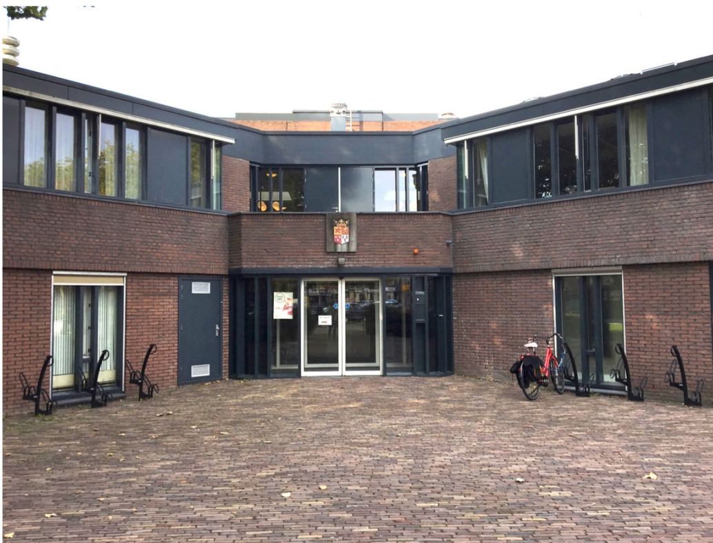
Foto 2 Gevel van het te slopen deel van het Wijkservicecentrum.
