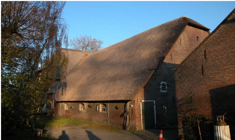
Stal en schuur Enghlaan 17
