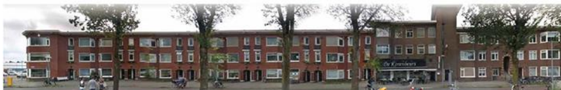
Illustratie: woningen aan de Croeselaan ter hoogte van het Beurskwartier; voor de bewoners wordt gezocht naar een passende alternatieve locatie.
