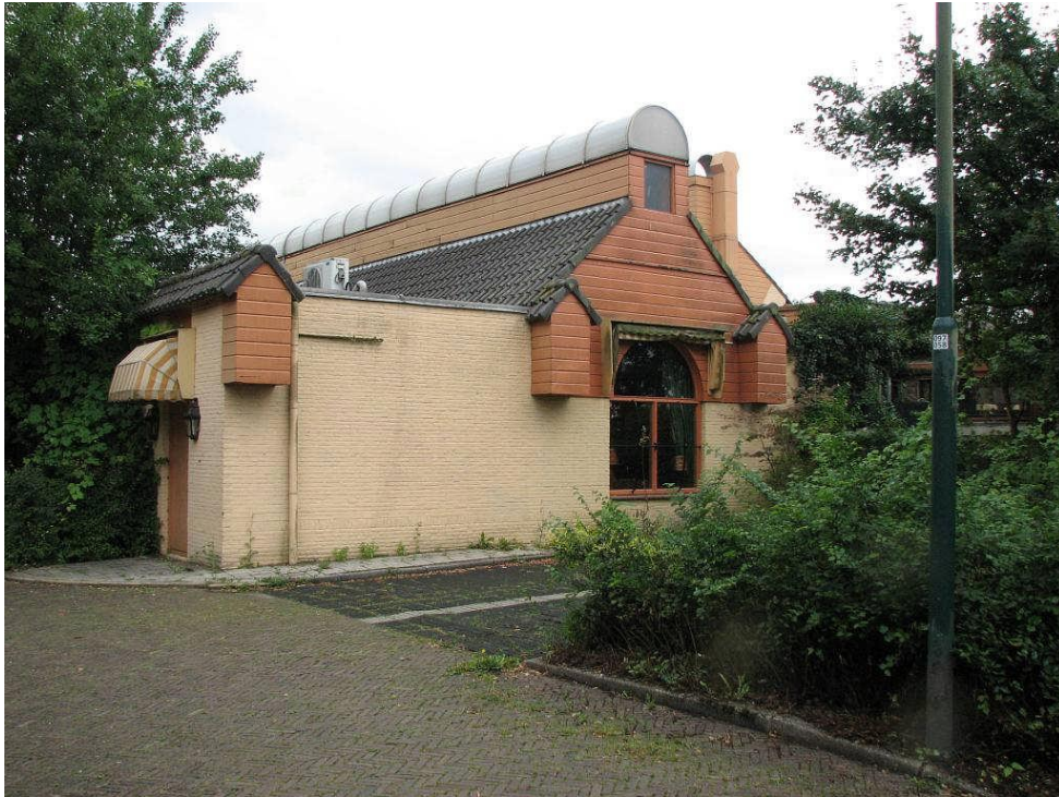
Foto 5: Overzichtsfoto van de achterzijde van het pand.
