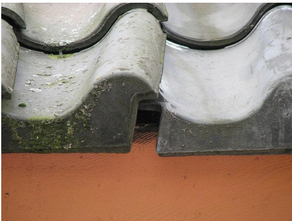
Foto 16: Mogelijke toegang tot een verblijfplaats van vleermuizen.
