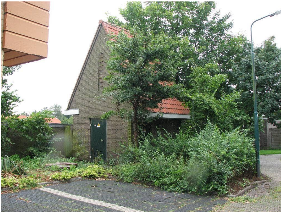
Foto 6: Overzichtsfoto van het trafogebouw.
