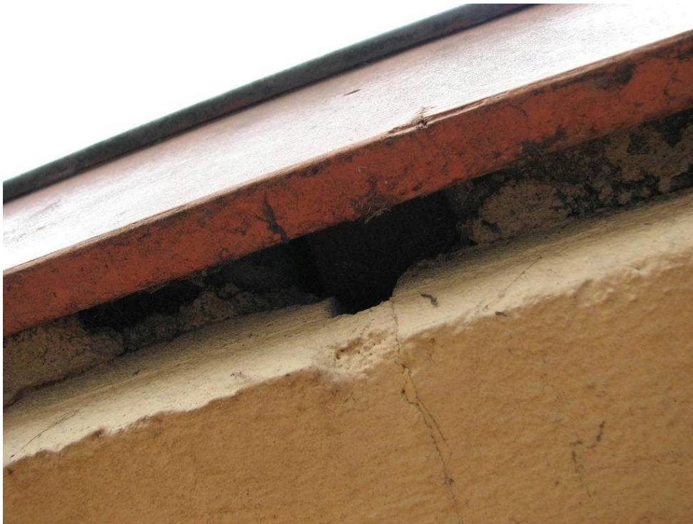
Foto 17: Mogelijke toegang tot een verblijfsplaats van vleermuizen.
