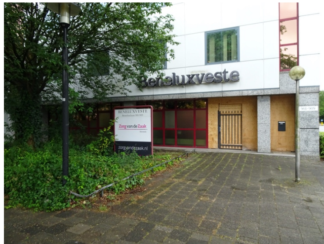
Beneluxveste afgesloten ingang oostzijde
