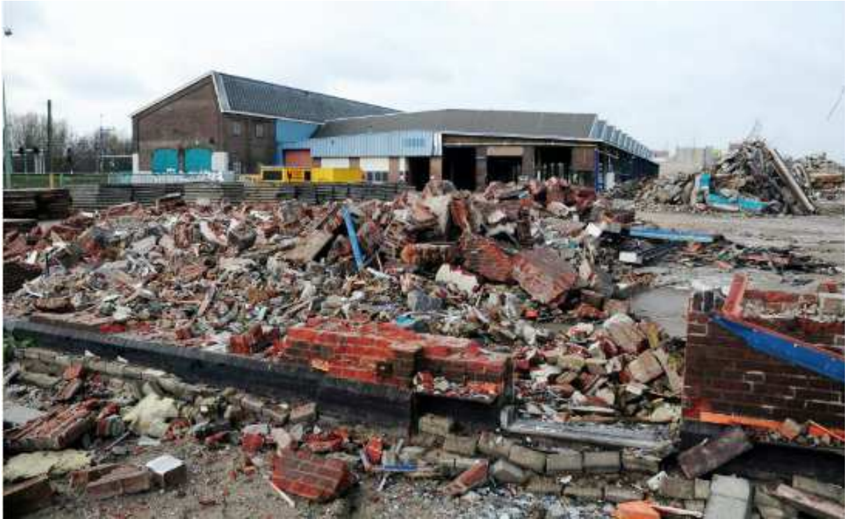
Foto uit januari 2012 van de zicht op de HTMU-loods (links) en de voormalige dieselloods van de N.S. (lijnwerkplaats Utrecht) met op de voorgrond de restanten van de gesloopte, voormalige wagenmakerij (later Electrorail N.V.). Het Utrechts Archief, catalogusnummer 808446 ( hetutrechtsarchief.nl ).
