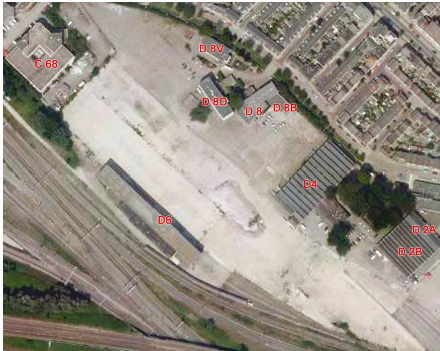
Figuur 16: Resterende bebouwing in deelgebied IV, C = Concordiastraat en D = 2 e Daalsedijk, met huisnummers.
