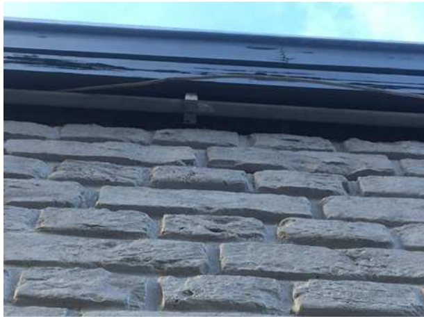
Detailopname van een boeiboord. Vleermuizen kunnen geen verblijfplaats bezetten tussen de buitengevel en boeiboord.
