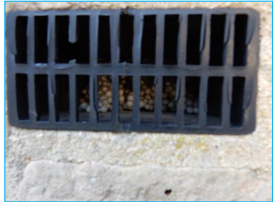
Foto's: Openingen naar potentiële verblijfplaats en goed zichtbare isolatiekorrels.
