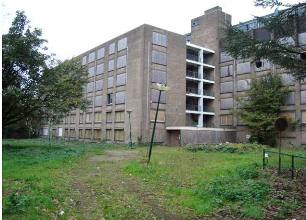
Foto 1. Noordelijke deel hoogbouw vanaf de entree aan de Albert Cuyplaan gezien.
