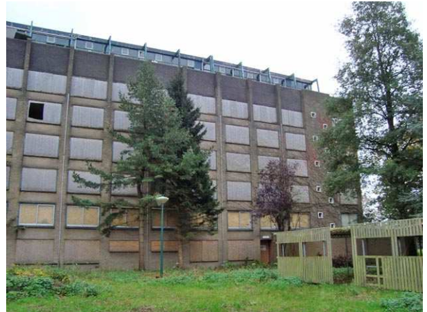
Foto 2. Zuidelijke deel hoogbouw vanaf de entree aan de Albert Cuyplaan gezien.
