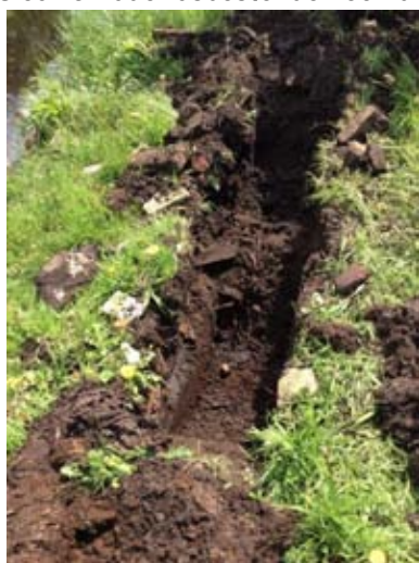
Sleuf 5 nader asbestonderzoek d.d. 3 mei 2018
