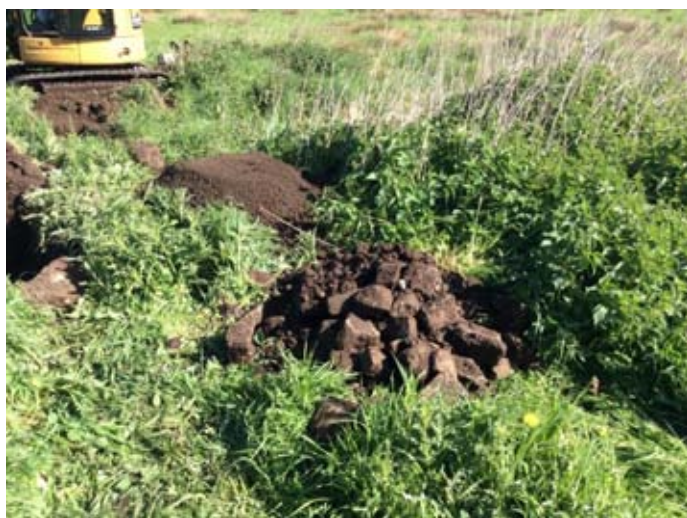
Sleuf 1 nader asbestonderzoek d.d. 3 mei 2018
