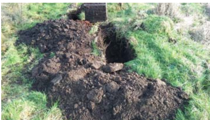
Gat 9 verkennend asbestonderzoek d.d. 8 februari 2018
