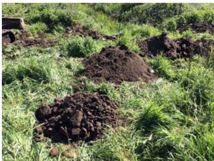
Sleuf 2 nader asbestonderzoek d.d. 3 mei 2018
