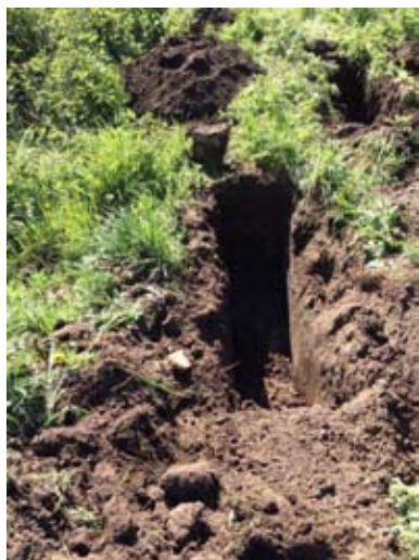
Sleuf 2 nader asbestonderzoek d.d. 3 mei 2018
