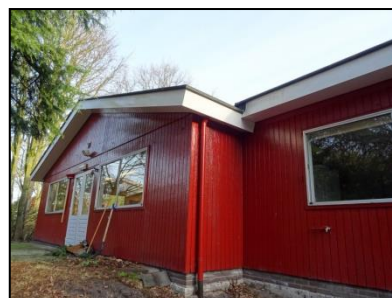
Figuur 11. Aanzicht schoolgebouw, gezien vanaf het zuiden.
