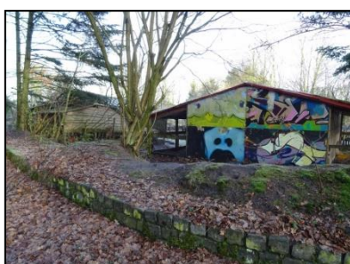
Figuur 16. Houten stal, gezien vanaf het zuidwesten.
