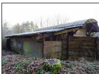
Figuur 15. Houten stal, gezien vanaf het zuidwesten.
