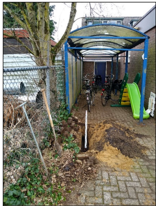
Afbeelding 8: De proefsleuf is gegraven op 50 cm vanaf de stamvoet van de esdoorn met boomnummer 1. Er is tot 60 cm diepte gegraven om het wortelpakket in kaart te brengen.
