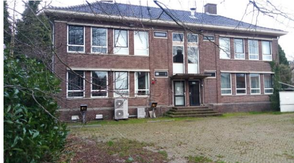
Foto 2: Achterzijde van het hoofdgebouw met parkeerplaatsen.
