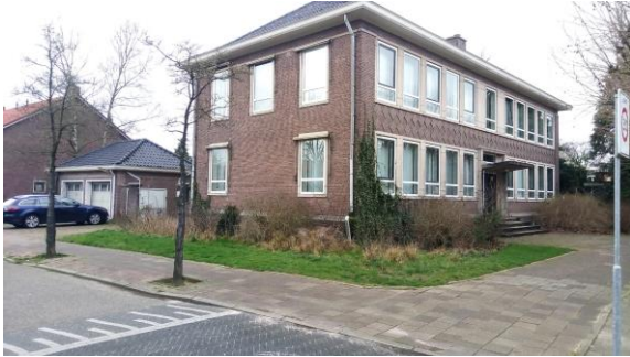
Foto 1: Aanzicht van de gebouwen vanaf de hoek Kampweg (Odijkplein) / Moerbessenberg
