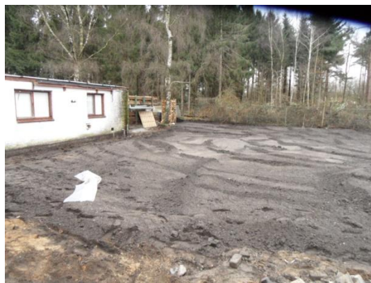
Foto 2: situering locatie vanuit zuidoostelijke richting
