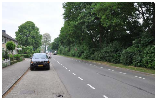
Huidige situatie Kampweg t.p.v. locatie Evenemententerrein
