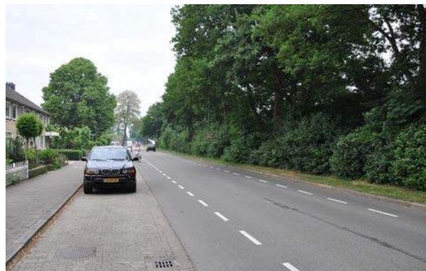
Huidige situatie Kampweg t.p.v. locatie Evenemententerrein
