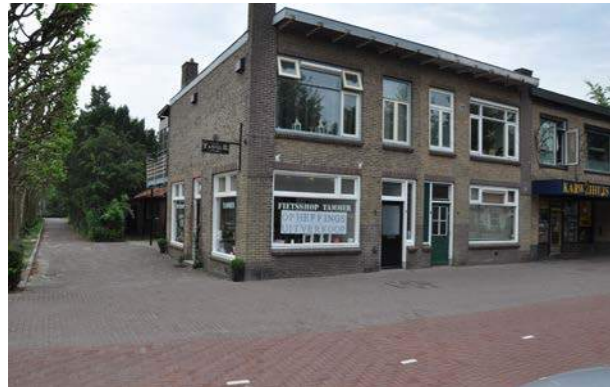
Winkelrouting en trekkers niet optimaal
