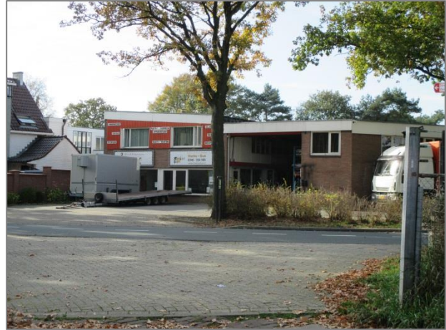
Te slopen bedrijfspand (2)
