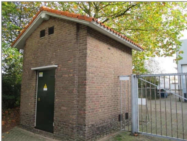
Te slopen trafo naast HYPSSOS (3)
