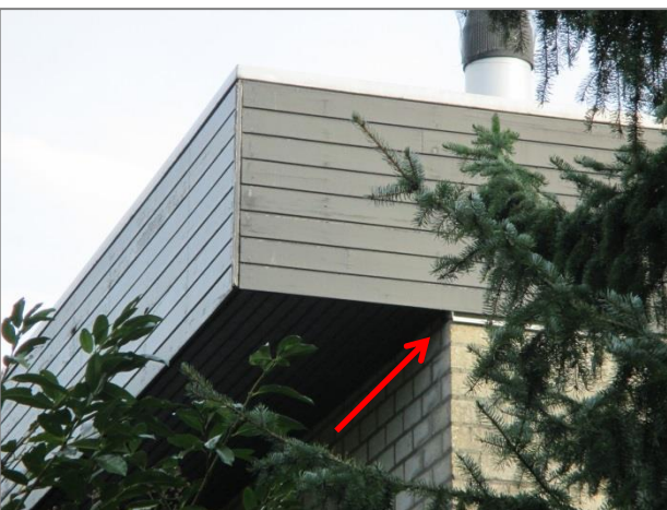
Locatie C | Houten dakrandconstructie, door opening toegankelijk.
