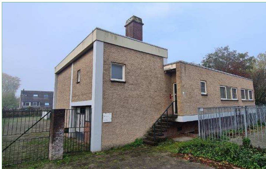
Oostgevel van de bebouwing.
