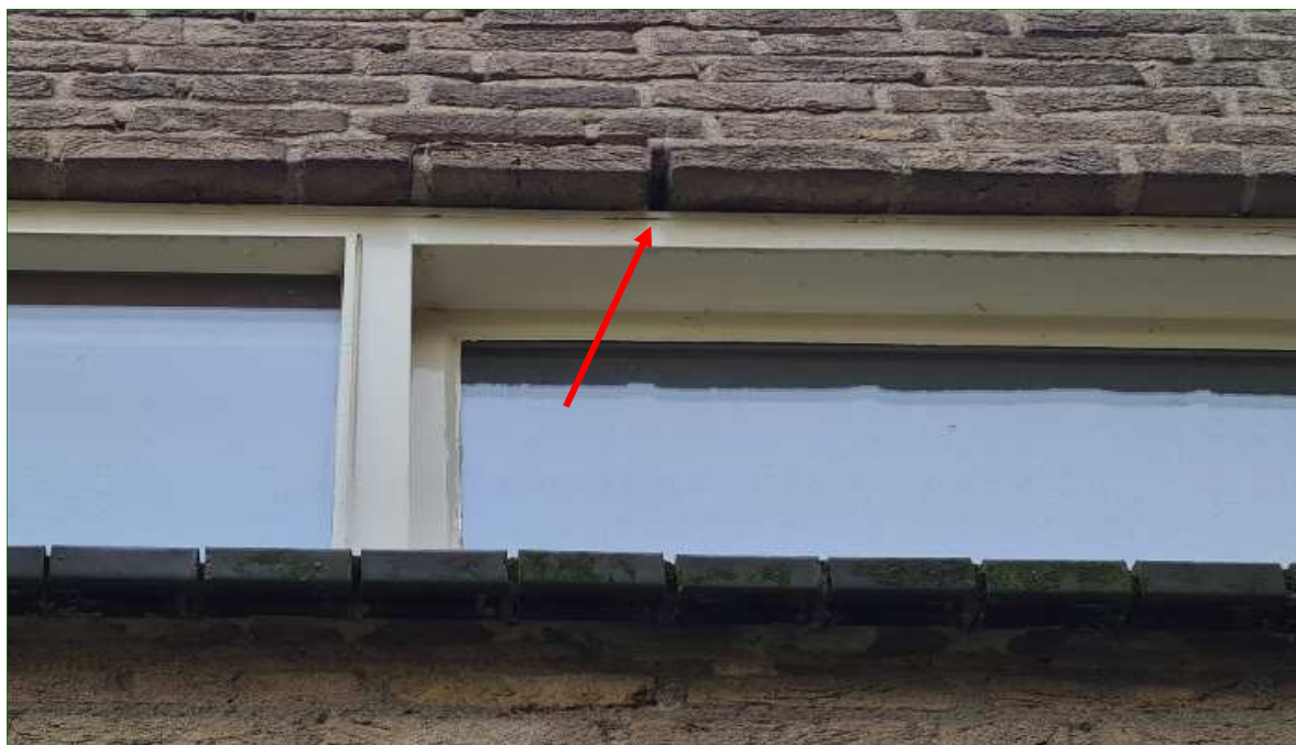
De openingen achter de regenpijp en in de spouwmuur (rode pijl) aan de noordoostzijde van de bebouwing geven mogelijk toegang tot voor vleermuizen geschikte achterliggende ruimtes.
