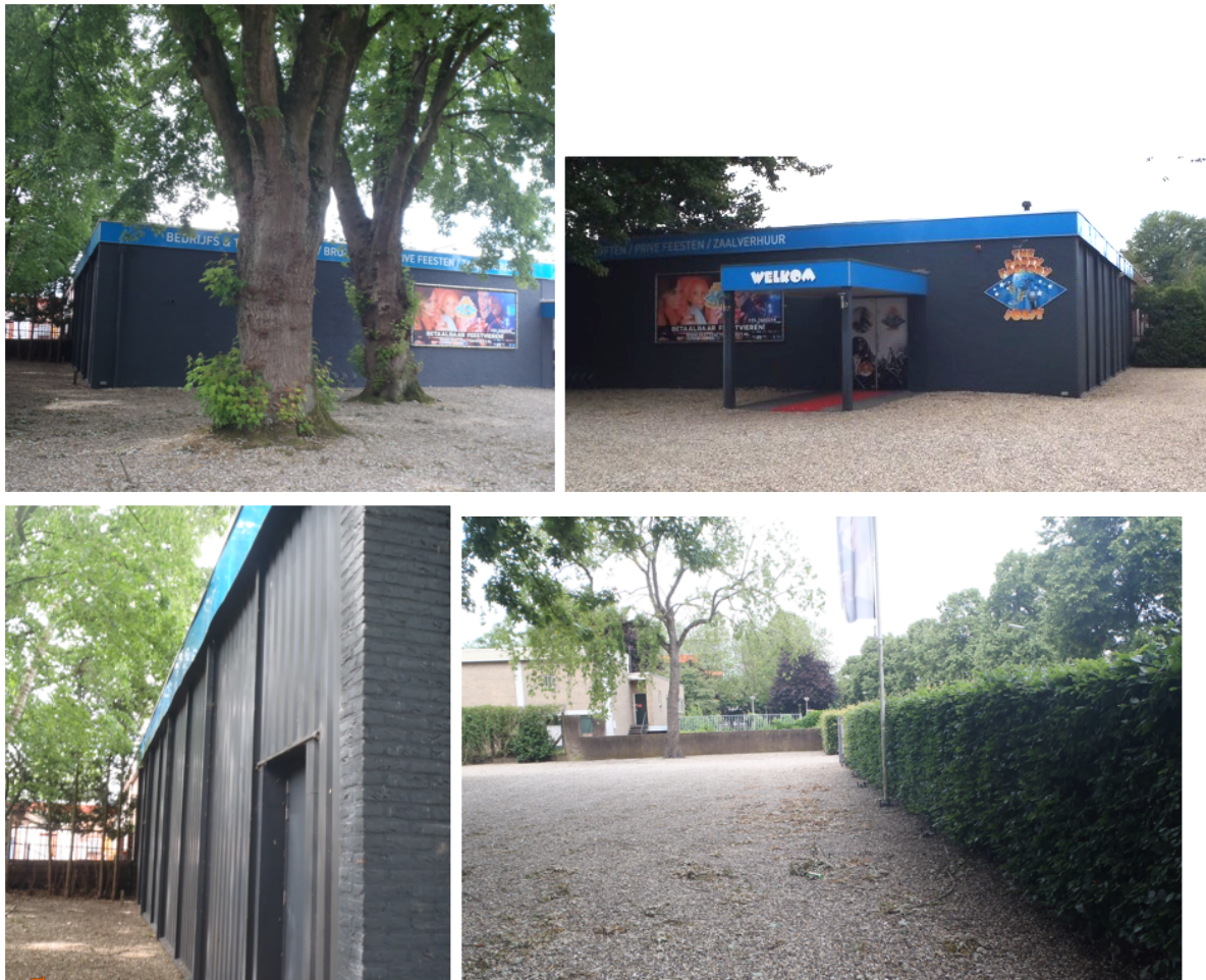
Afbeelding 7-10: Het te slopen gebouw en het terrein
