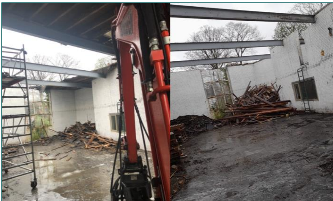
Figuur 3.2 Foto's van het verwijderen van het dak.
