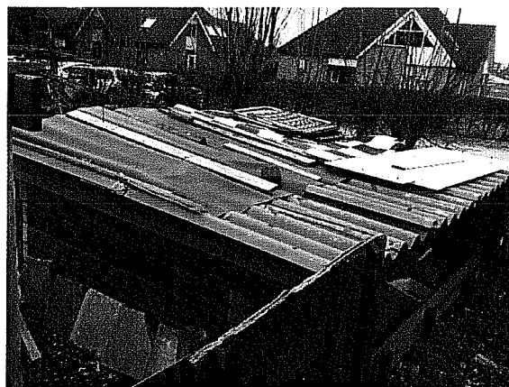
Foto 6: schuurtje met asbest verdachte dak
