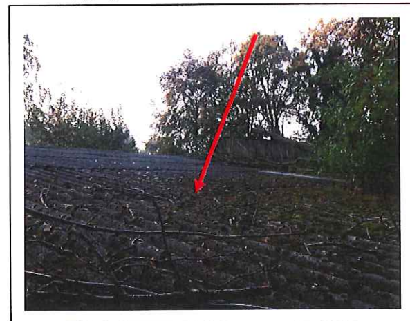
Foto 6: golfplaten (bron 3: M3) op dak paardenstal/wagenberging
