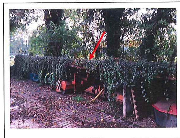
Foto 11: groot afdak met daarop golfplaten (bron 6: M5) als dakbedekking
