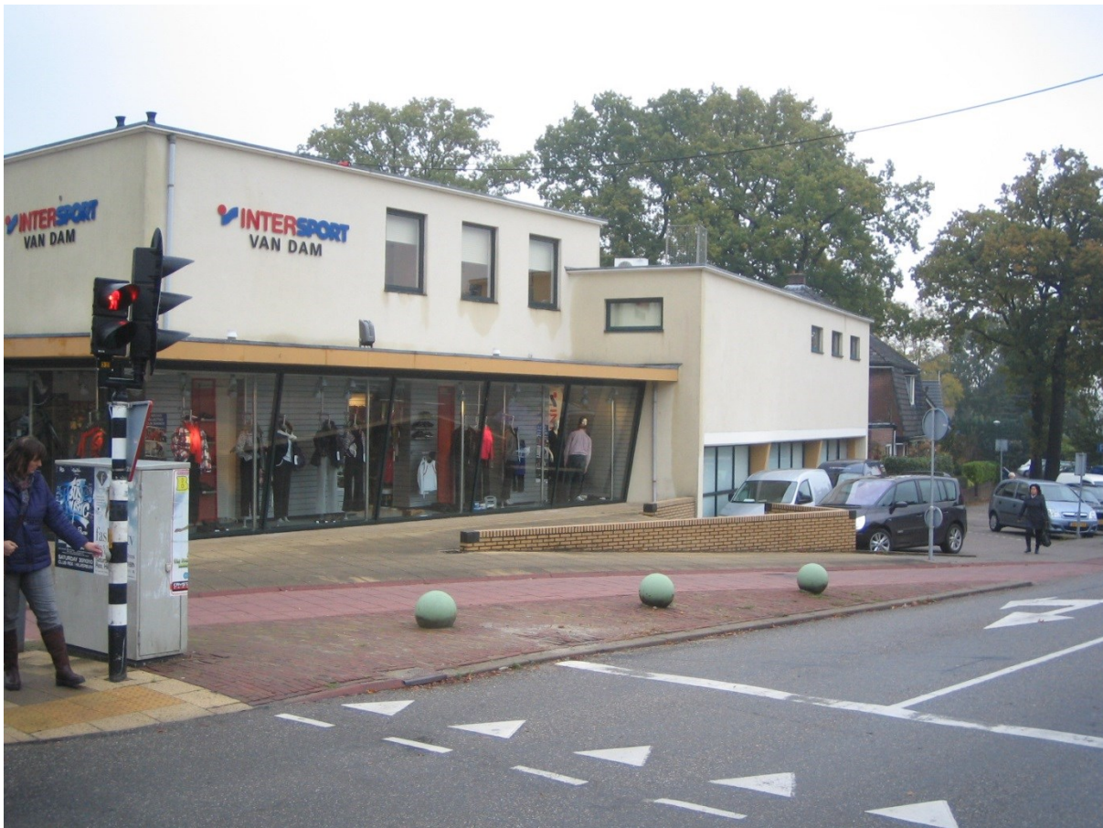
Het bestaande pand van Weedestraat 62
