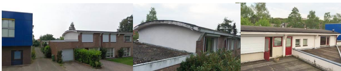
Situatie bestaande bedrijfswoning t.o.v. het fitnesscentrum. Links voorzijde- rechts achterzijde
