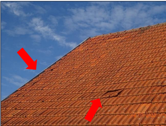
Afbeelding 9 Dak woonhuis met mogelijke nestlocaties huismus en gierzwaluw
