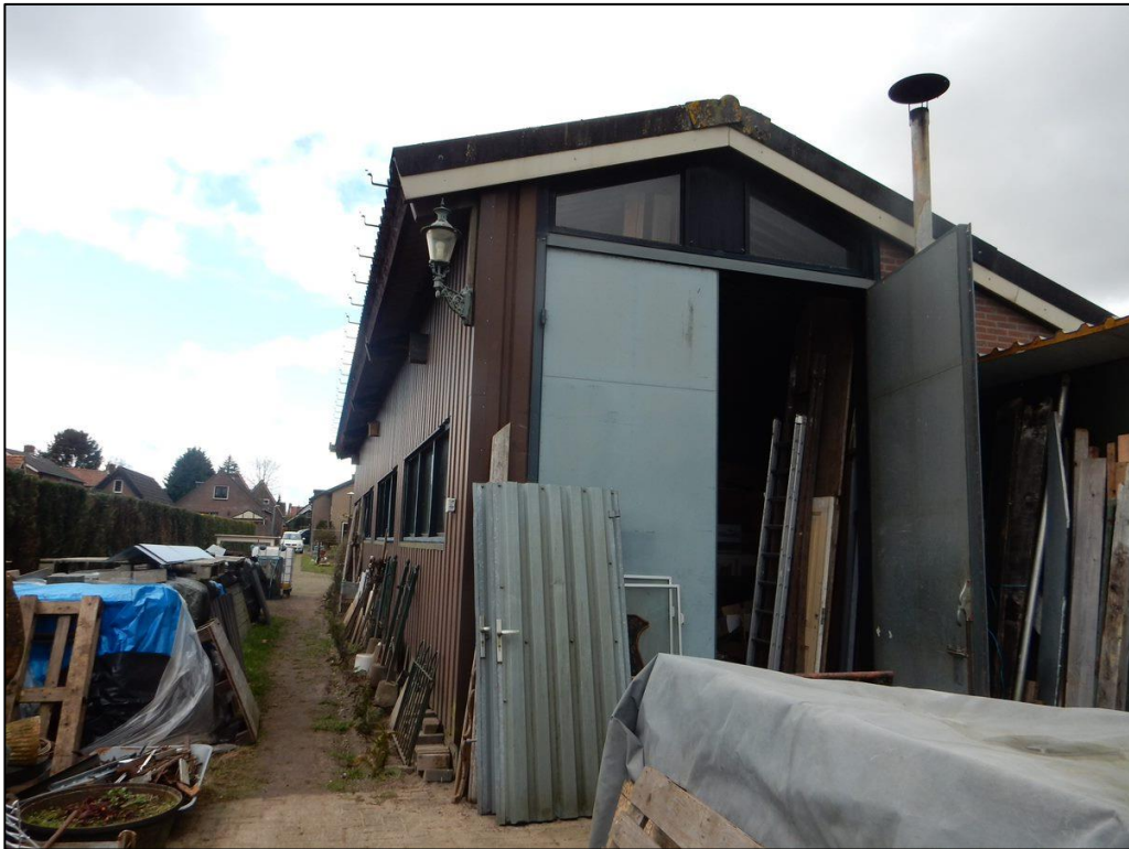
Figuur 1 Het bedrijfsgebouw. Deze bebouwing zal gesaneerd worden.
