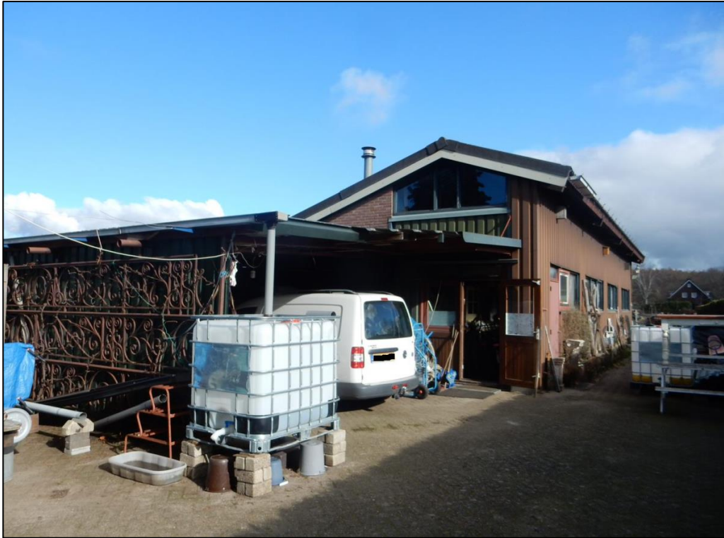
Figuur 2 Fotografische indruk van het te saneren bedrijfsgebouw op de planlocatie.
