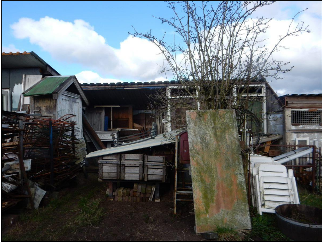
Figuur 3 Schuur 2. Dit gebouw zal gesaneerd worden.
