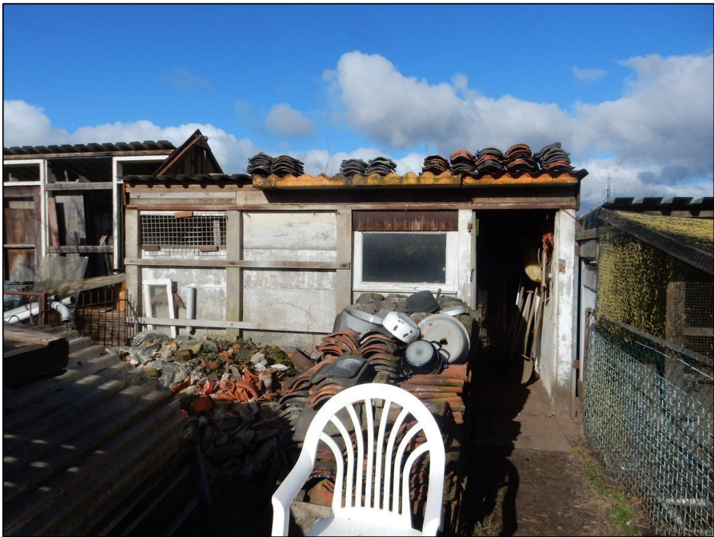
Figuur 4 Schuur 3. Dit gebouw zal gesaneerd worden.
