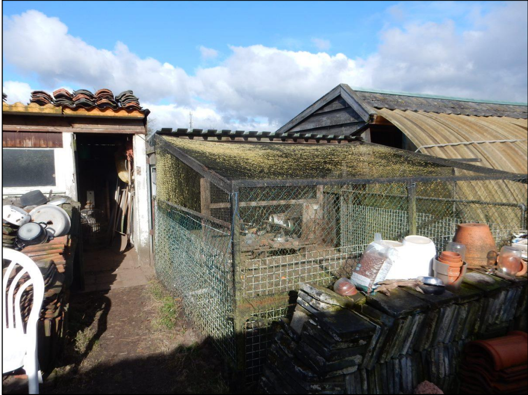
Figuur 5 Het kippenhok. Dit gebouw zal gesaneerd worden.
