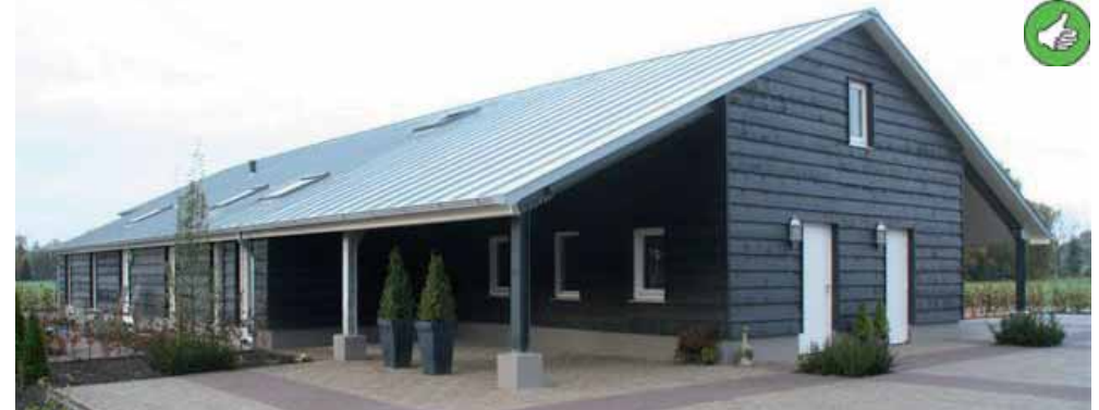
Voorbeeldfoto 1. Functieverandering van een stal naar woongebouw. Voldoet aan de richtlijnen van een goede vormgeving en dak-gevelverhouding.
