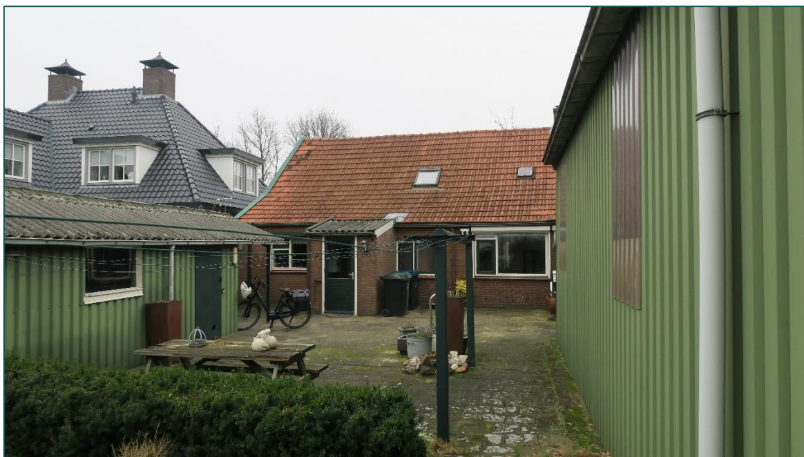
Figuur 1 De planlocatie is gelegen aan de Zwijnsbergen 31-31A te Elst en bestaat uit een twee-onder-één-kapwoning, schuur met paardenstalling (nr 2, rechts op de foto) en twee kleine schuren (nr 3, links op de foto). Op de foto is tevens een van de uitbouwen (entrees) zichtbaar.
