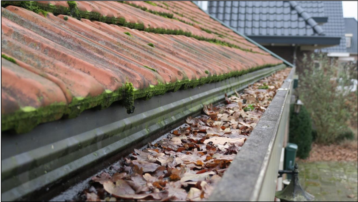
Figuur 3.3 De ruimte tussen dak en dakbeschoot is niet toegankelijk voor de huismus (gierzwaluw of vleermuizen).
