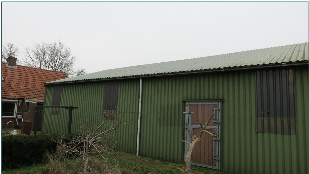
Figuur 1.3 Op de planlocatie is men voornemens om de schuur te slopen ten behoeve van de bouw van een twee-onder-één-kapwoning. Op een later moment zal ook de huidige twee-onder-één-kapwoning en schuur 3 & 4 gesloopt worden ten behoeve van de bouw van een nieuwe vrijstaande woning.
