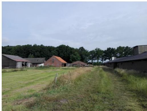
Zicht achter op het erf: te slopen bebouwing
