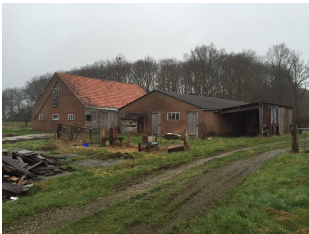
Figuur 2 De te slopen schuren bestaan uit een kapschuur, grupstal en een varkensschuur. De schuren zijn momenteel niet meer in gebruik.
