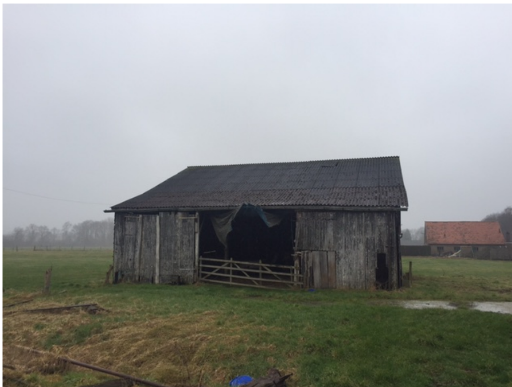
Figuur 3 De schuren verkeren in matige staat van onderhoud bestaan uit stenen muren, houten wanden, daken met golfplaten en/of dakpannen.
