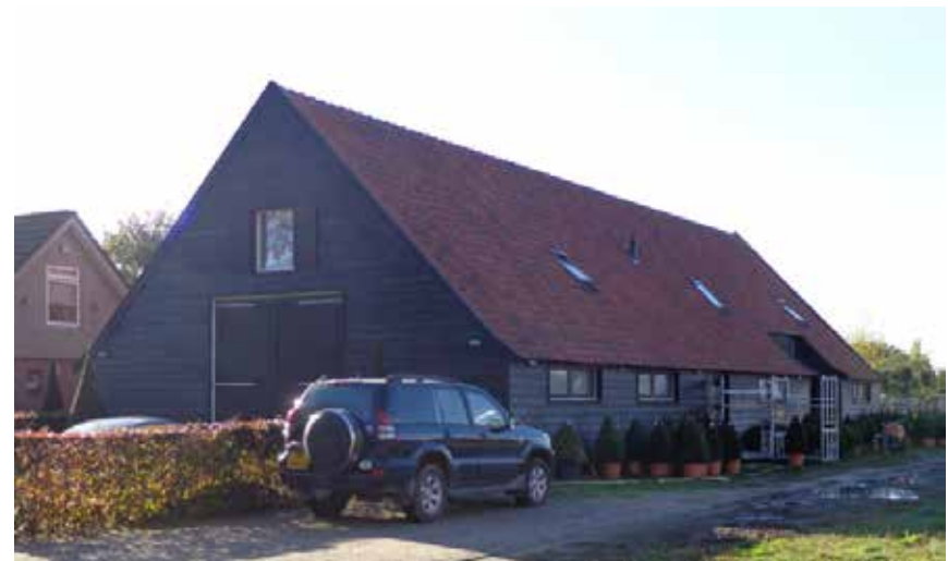
Schuur (bedrijfspan) aan de Vissersweg behorende bij woning 44.
