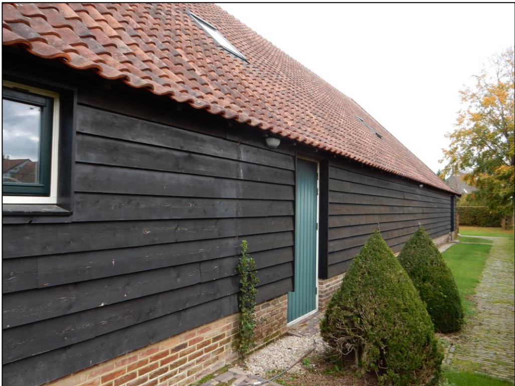
Figuur 4 De zuidzijde van de schuur gelegen op de planlocatie.
