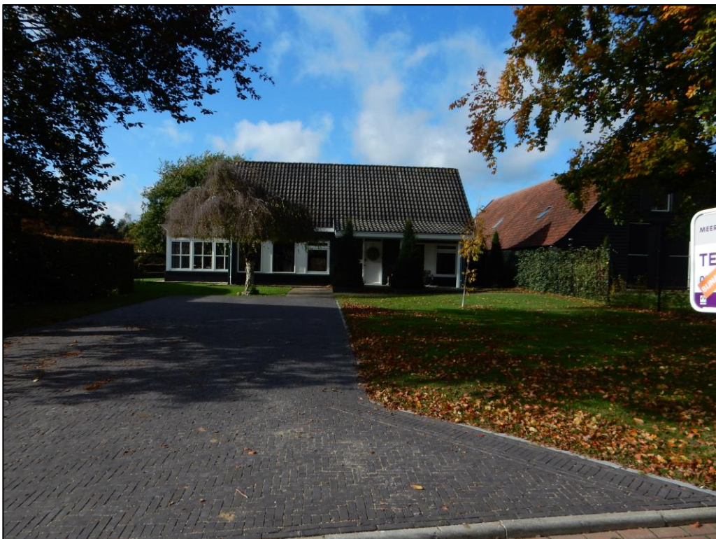
Figuur 2 De oostzijde van de bedrijfswoning gelegen op de planlocatie.
