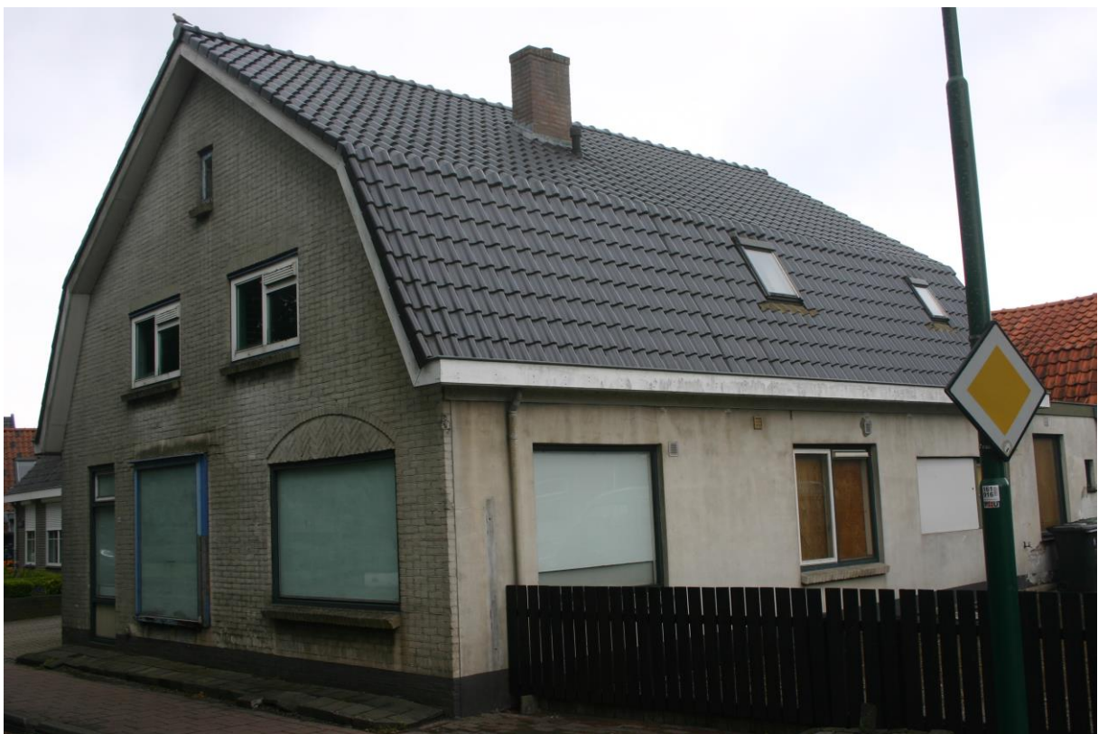
Figuur 3. Het leegstaande woonhuis op nr. 147
