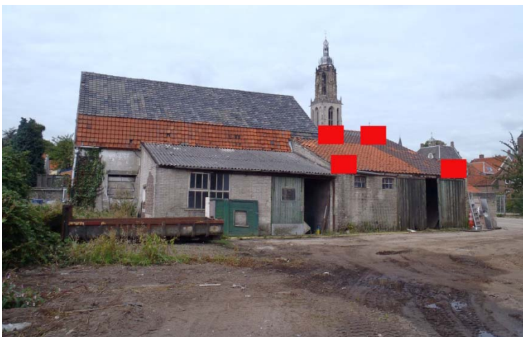
Figuur 8. Foto van de overige te slopen bebouwing, met hierop de locaties van de te verwijderen dakpannen (rood). De op de foto aangegeven locaties gelden voor beide zijden van het gebouw.
