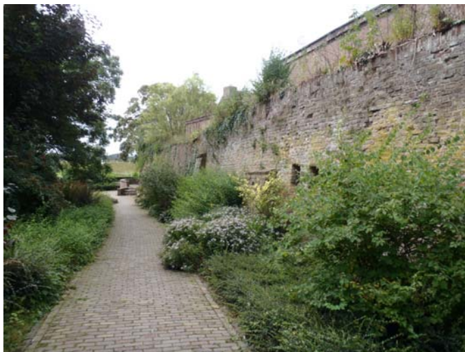
Figuur 4. De oostelijke oude stadsmuur ter plaatse van de vleermuisverblijven.
