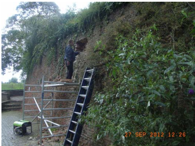
Figuur 5. De meest zuidelijke locatie aan de stadsmuur, tijdens de realisatie van de vleermuisverblijven.
