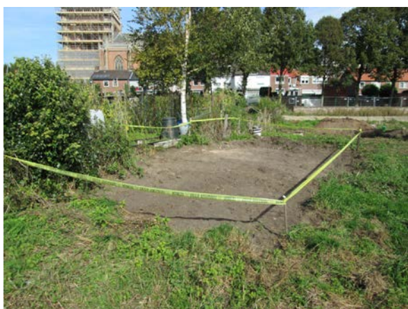
Foto 3: Aanzicht van de ontgraving na afronding (1)
