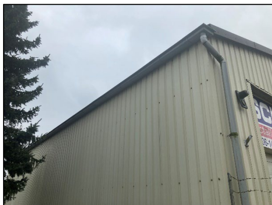
Figuur 1.12 (links): De noordzijde van de garage bestaat uit damwand. Langs de bovenzijde loopt een dakgoot; Figuur 1.13 (rechts): De binnenzijde van de garage.
