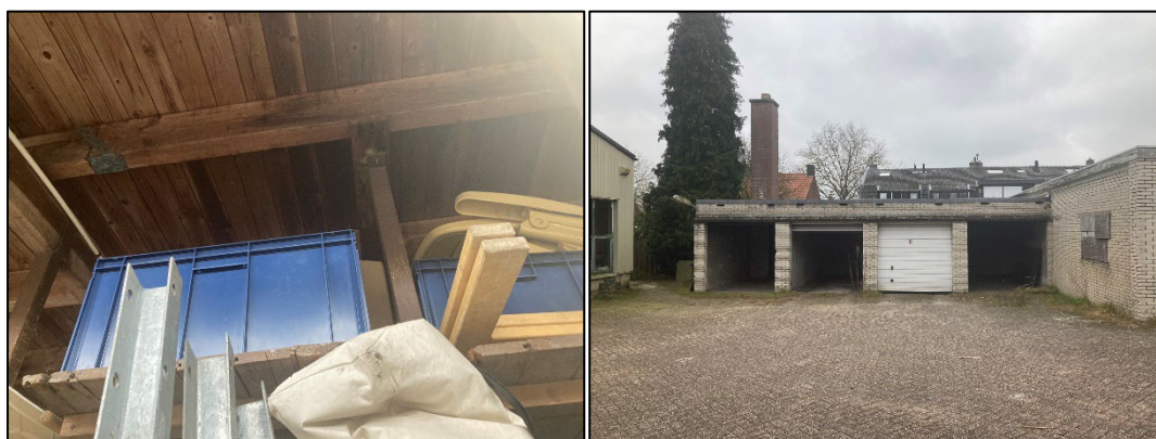
Figuur 1.6 (links): De binnenzijde van de opslag, het plafond is hier gemaakt van houten planken, met daarop een plat dak; Figuur 1.7 (rechts): De garageboxen, op de meer linker garagebox staat een schoorsteen.
