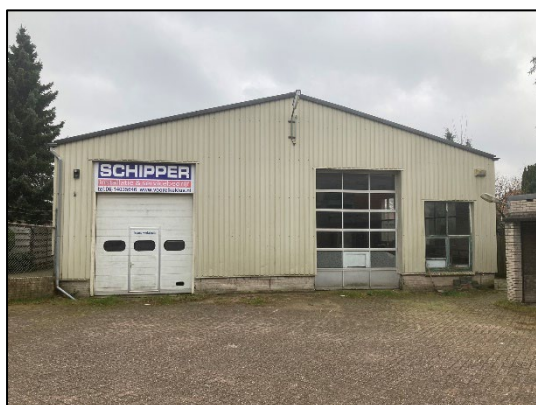
Figuur 1.10 (links): De voormalige garage bestaat uit damwand met een gemetselde onderkant. Het dak is opgebouwd uit houten panelen met daarbovenop golfplaat; Figuur 1.11 (rechts): De achterzijde van de garage bevat een aantal ramen. De muur is gemetseld en bevat geen stootvoegen.
