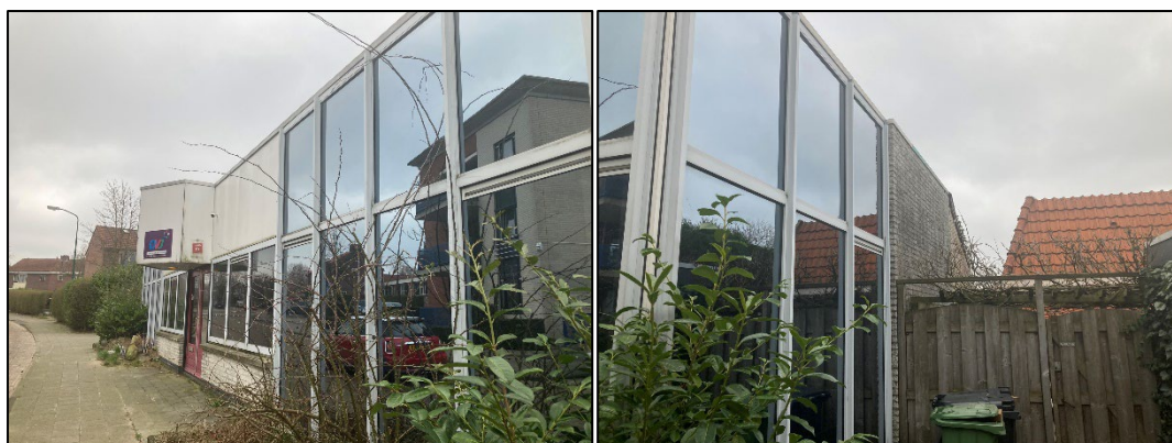
Figuur 1.2 (links): De oostzijde van het plangebied. Hier is begroeiing in de vorm van struiken aanwezig; Figuur 1.3 (rechts): De zuidzijde van de bebouwing grenst aan tuinen. De muren bevatten geen stootvoegen.
