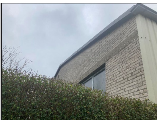
Figuur 1.10 (links): De voormalige garage bestaat uit damwand met een gemetselde onderkant. Het dak is opgebouwd uit houten panelen met daarbovenop golfplaat; Figuur 1.11 (rechts): De achterzijde van de garage bevat een aantal ramen. De muur is gemetseld en bevat geen stootvoegen.
