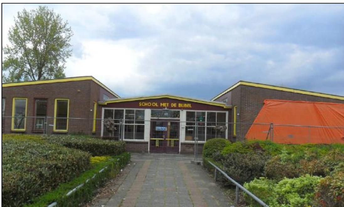
Afbeelding: de inmiddels gesloopte schoolbebouwing, gezien vanaf de Beatrixstraat
