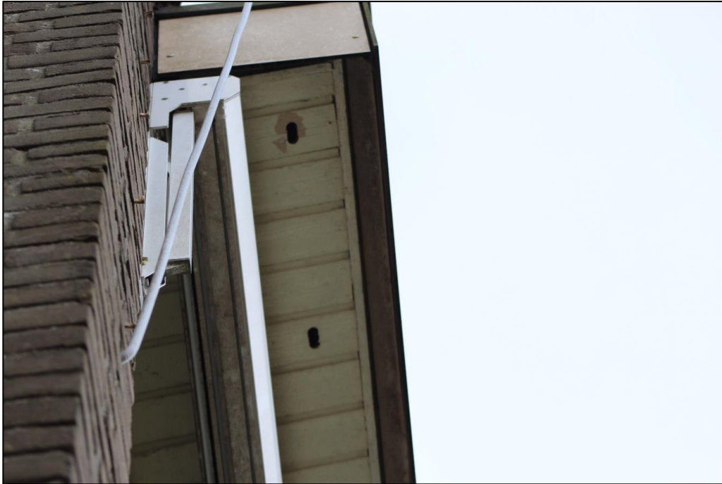
Figuur 3 Openingen in de houten schrootdelen van het gezondheidscentrum kunnen door de gierzwaluw worden gebruikt als inliegopeningen.
