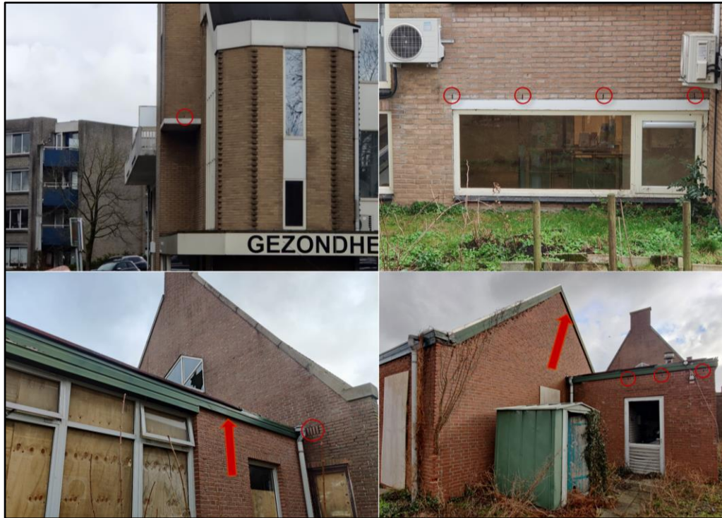
Figuur 4 het kerkgebouw met aanbouwen en het gezondheidscentrum vertonen openingen als open stootvoegen en ruimtes onder het boeiboord waar het voorkomen van vaste rust- en/of voortplantingsplaatsen van gebouw bewonende vleermuizen niet uitgesloten kan worden.
