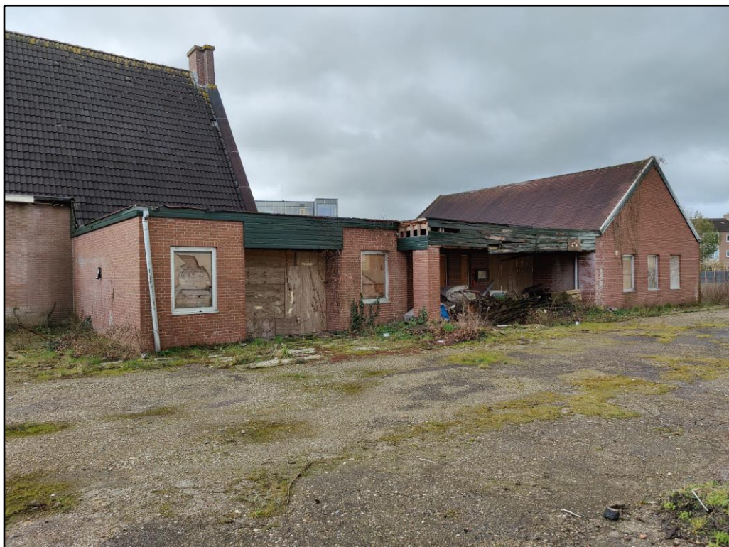
Figuur 2 Het kerkgebouw en bijbehorende aanbouwen verkeren in een vervallen staat en vertoonde tijdens het veldbezoek sporen van recentelijke (illegale) bewoning.
