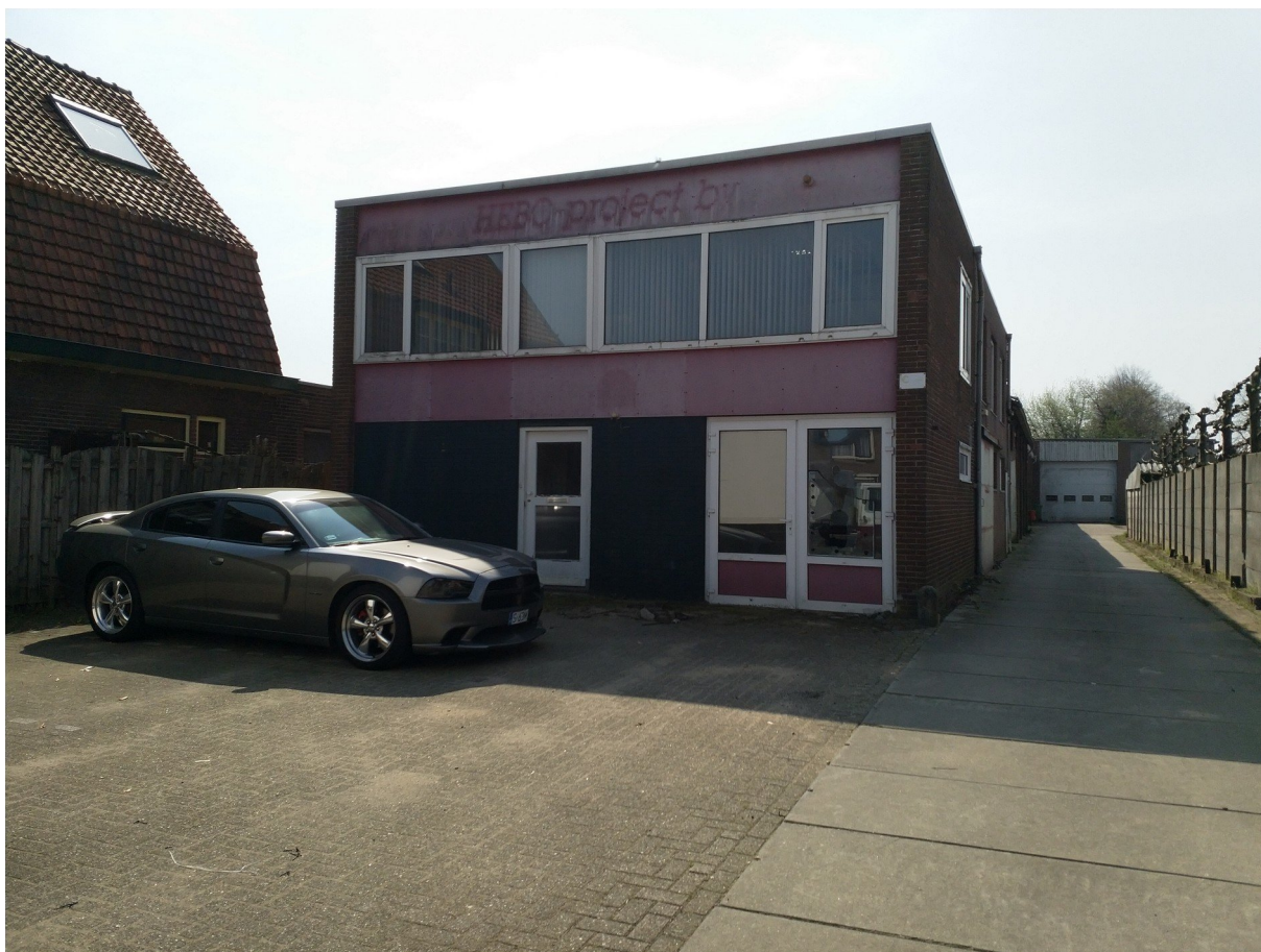
Voorgevel kantoorgedeelte Franseweg 95 straatzijde. Foto: M. de Vries | Ecoresult B.V.
