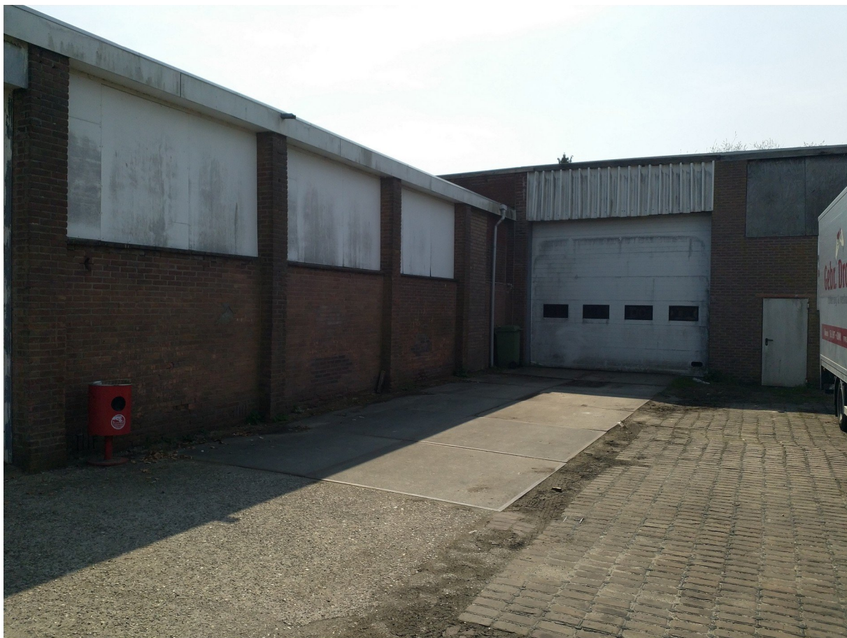
Voorgevel zuidelijke lood Franseweg 95 met roldeur. Foto: M. de Vries | Ecoresult B.V.
