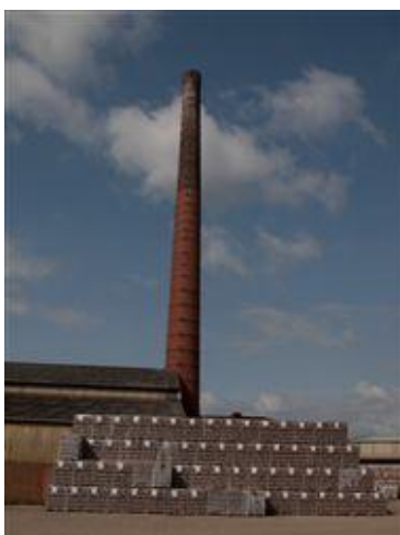
Afbeelding 2. De schoorsteen op het terrein van de voormalige steenfabriek (Bron: Utrechtse Stichting voor Industrieel Erfgoed (USINE)).
